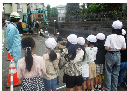
4年生水道教室 (5/26) 市水道局による授業 水道工事の現場に学ぶ
